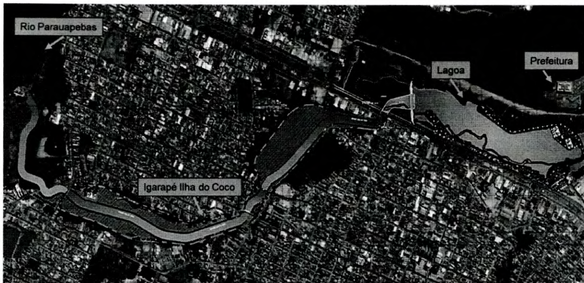
Figura 4 - Trecho do Igarapé Ilha do Coco compreendido na Primeira Etapa do Programa.
