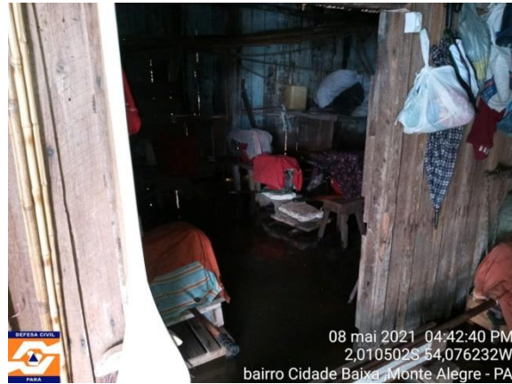
Residência de morador que desalojou e seus pertences ficaram no imóvel
