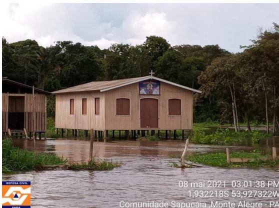
Igreja de comunidade sem acesso por passarela
