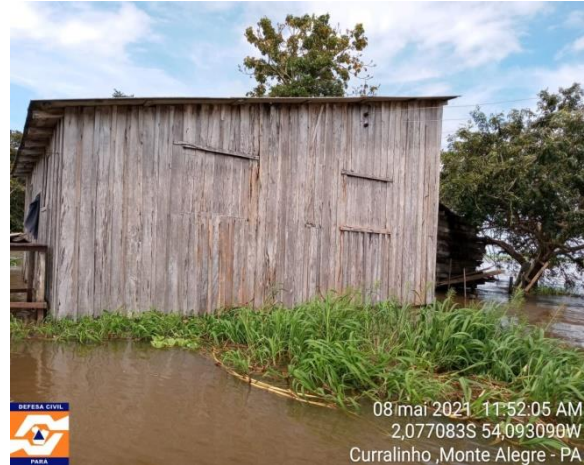
Casa em risco de inundação interna
