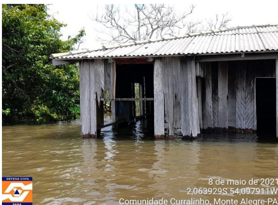
Casa com as paredes danificadas por ondas provocadas pelas embarcações e temporais
