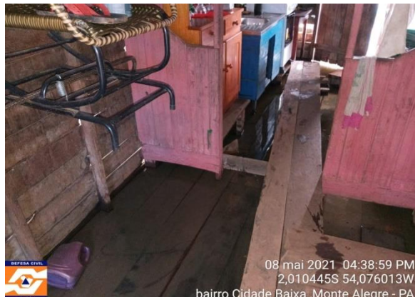
Imóvel com marombas sendo instalada
