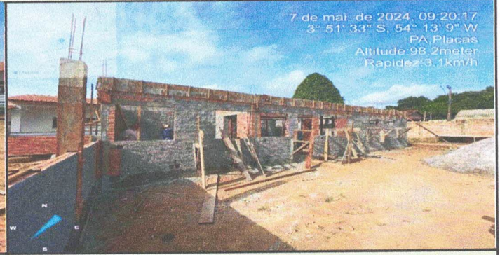
FOTO 08: VISTA DO BLOCO DE SERVIÇO
