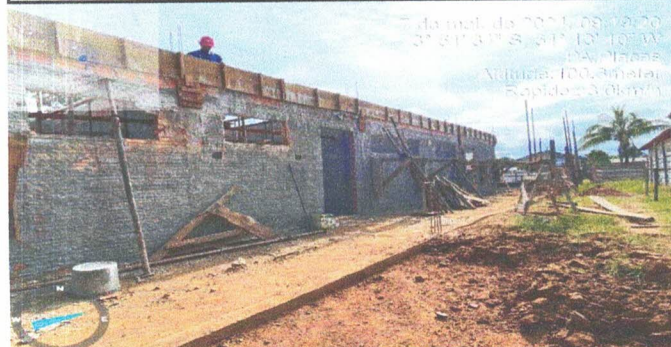
FOTO 05: VISTA DO BLOCO DE SERVIÇO
