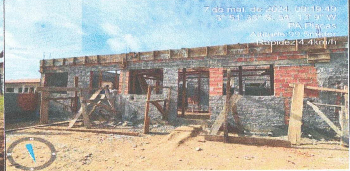
FOTO 06: VISTA DO BLOCO DE SERVIÇO
