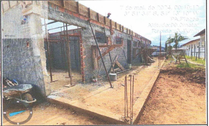
FOTO 02: VISTA DO BLOCO DE SERVIÇO
